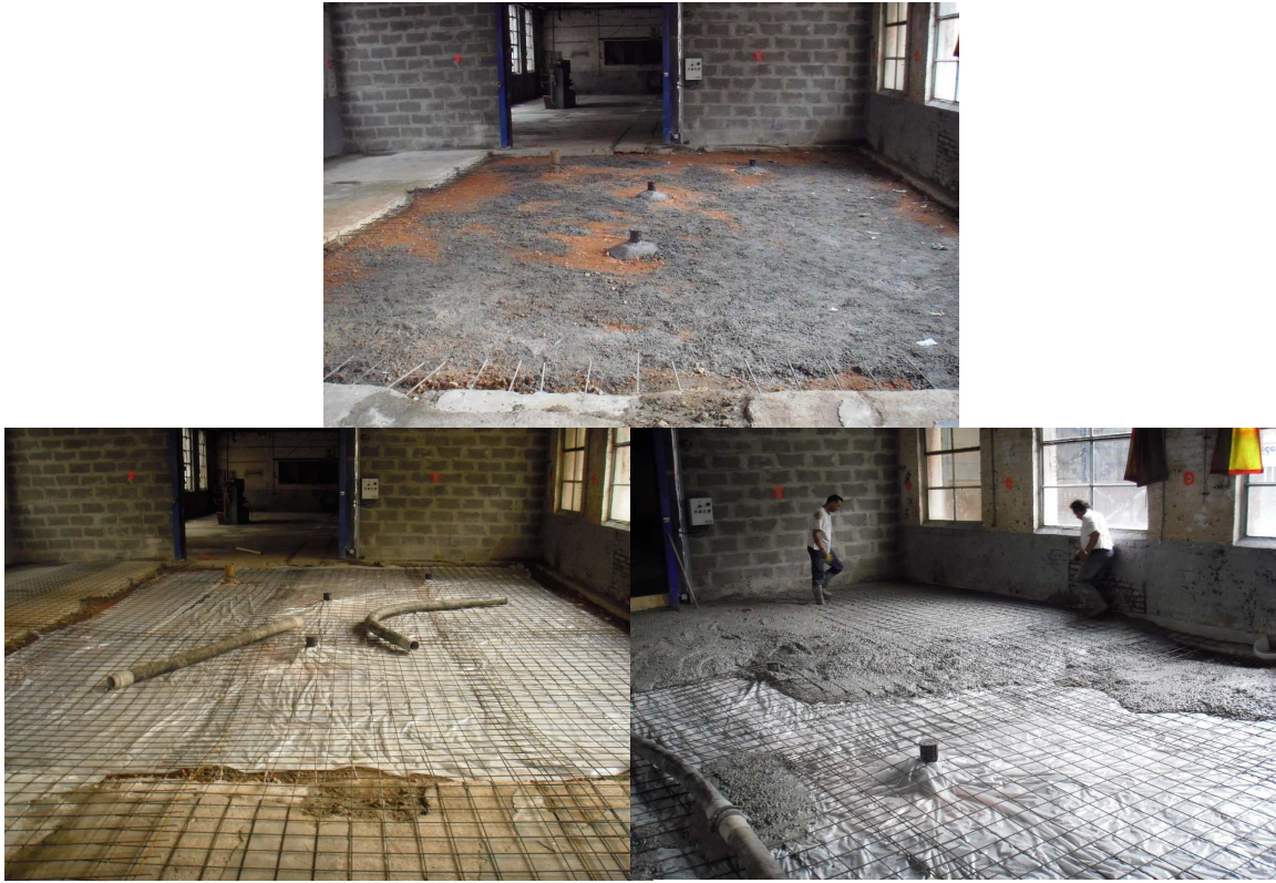
Figure 25 : Réfection de la dalle
