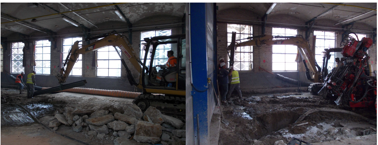
Figure 10 : Fichage des profilés HEB 200
