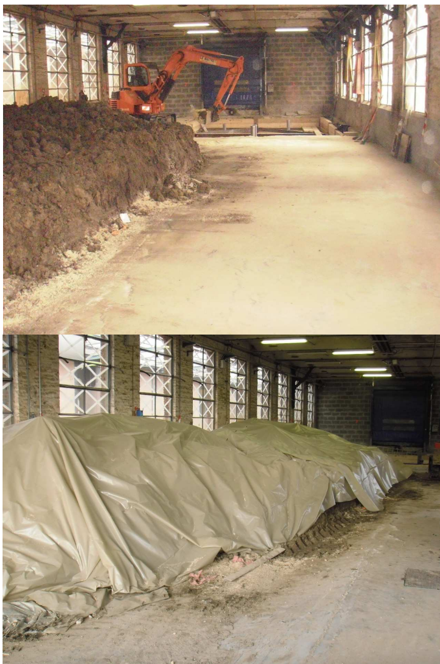
Figure 22 : Stockage des terres polluées dans le bâtiment avant chargement des camions pour évacuation
