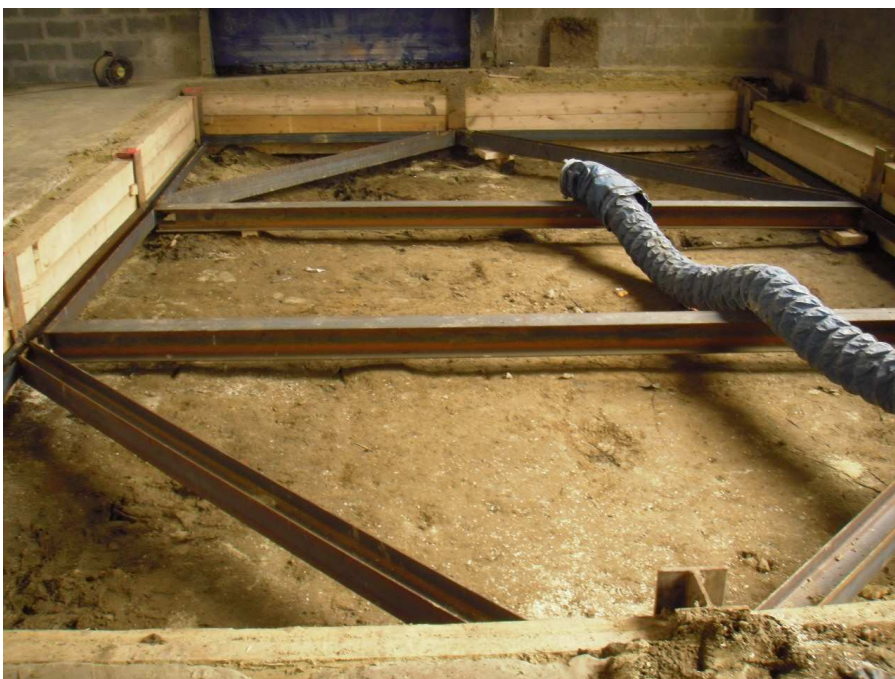
Figure 14 : Pré-terrassement et lit de butons
