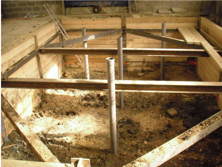
Figure 21 : Terrassement réalisé jusqu'à -2,5m/TN et réservations mises en place
