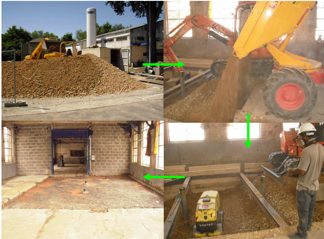
Figure 23 : Phasage remblaiement
